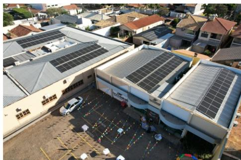
Alinhados à sustentabilidade, o Sistema OCB/MS aderiu à energia solar fotovoltaica em sua sede, em Campo Grande. Foram instaladas 80 placas solares de 550 W, e com isso, será evitada a emissão de 8,3 toneladas de CO2 por ano e 264 árvores serão preservadas anualmente.
